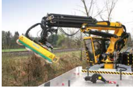
ASTSÄGEN ZUM FREISCHNEIDEN DES LICHTRAUM- PROFILS ENTLANG DER TRASSE
