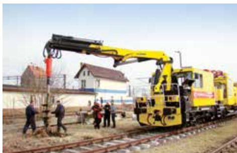
ERDBOHRER ZUM HERSTELLEN VON MAST- FUNDAMENTEN
