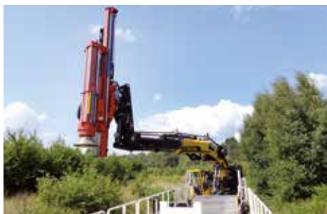
RAMMEN ZUM EINRAMMEN VON MASTFUNDAMENTEN
