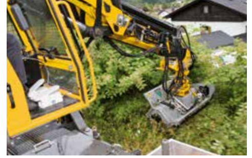
MULCHER ZUR BESEITIGUNG DES BEWUCHSES ENTLANG DER TRASSE
